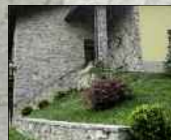
Muratura, copertine e pilastro
