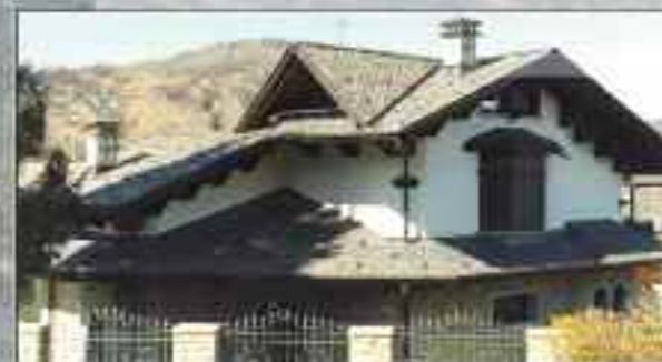
Tetto in ambiente alpino
