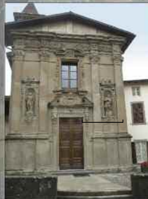
Facciata della chiesa di Gromlongo (comune di Palazago), interamente in arenaria
