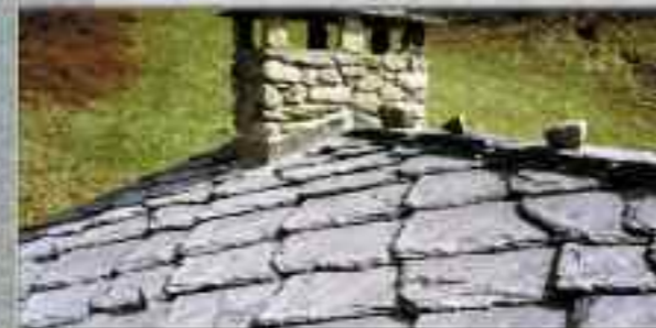
Particolare di copertura alla valdostana con colmo caratteristico
