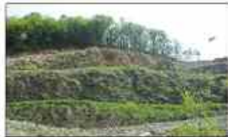
Fronte di una cava di pietra di Credaro: si notino i gradoni in coltivazione ed i corsi di roccia
