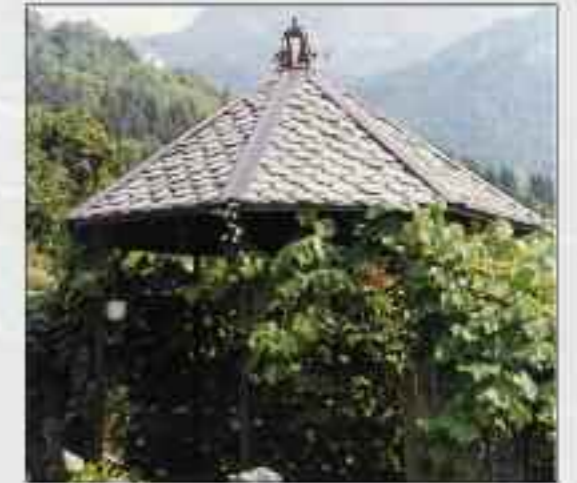
Copertura di un gazebo
