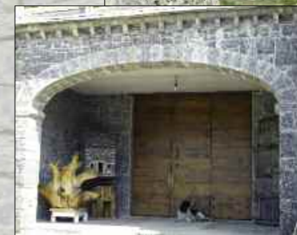
Esempio di uso strutturale della pietra e del perfetto abbinamento col legno
