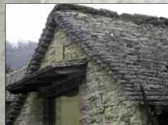
Copertura di una tipica costruzione rurale valdimagnina
