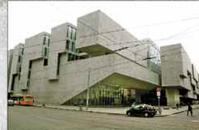
Università Luigi Bocconi - Milano Edificio dell'anno 2008 - World Architecture
