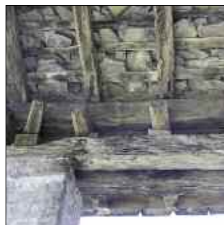
Dettaglio costruttivo: falda del tetto visto dall'interno
