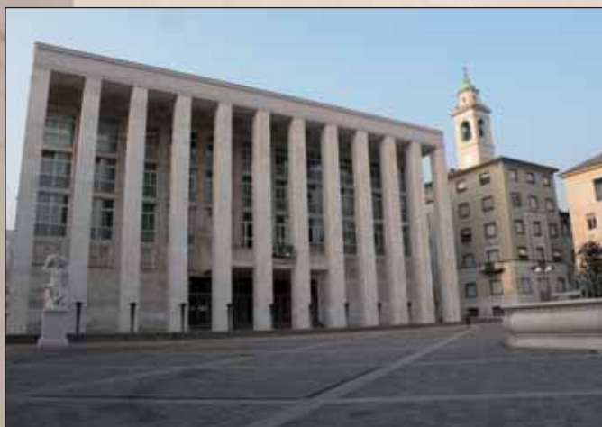
Bergamo, Piazza della Libertà, ex-casa del Fascio (1936-40)
