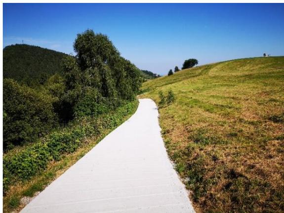
Il fondo è cementato, con piccole scanalature che permettono il deflusso dell'acqua piovana.
