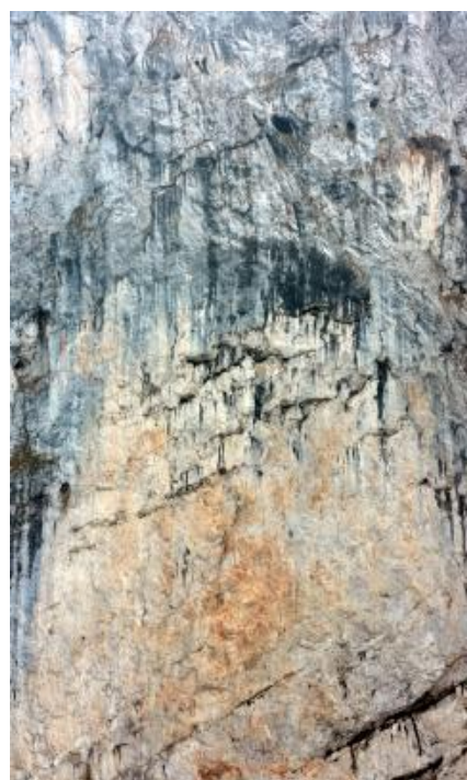
Figura 10 - Parete nord della Presolana interamente costituita dalla facies di margine e di pendio del Calcare di Esino.
