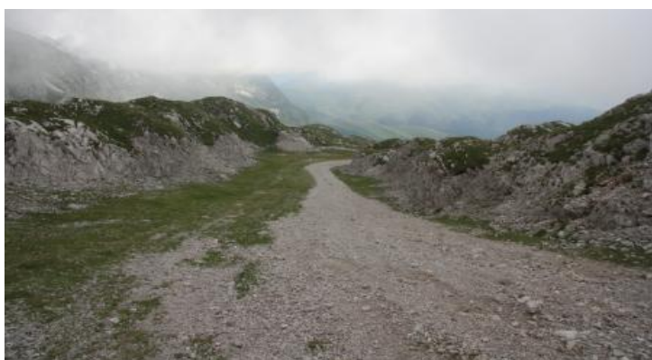
Figura 31 - Impatto della realizzazione del comprensorio sciistico di Colere, che ha visto anche l'apertura di una strada di servizio che da Cima Bianca conduce al Rifugio Albani. Si consideri che la strada raffigurata ha una carreggiata larga solo 5-7 m, mentre le piste raggiungono 50-55 m di larghezza.
